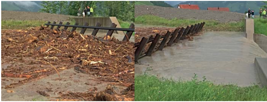
Bild 4. Holzablagerungen im Rechen (Fotos: R. Holdener).
