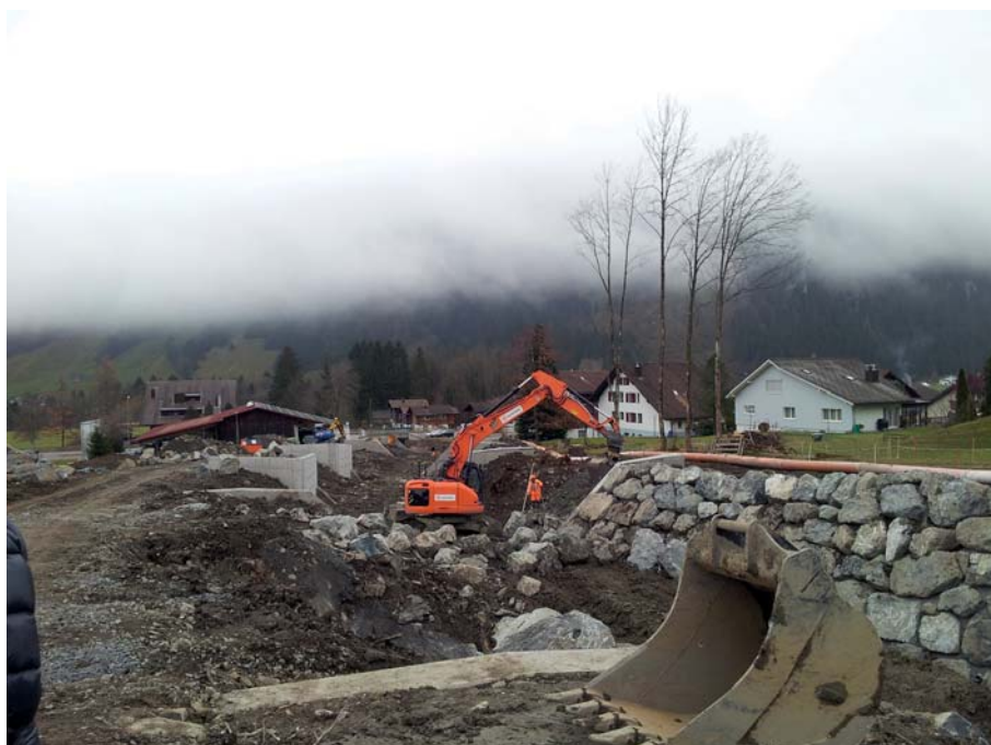
Bild 9. Bau der Ausleitstrecke im Herbst 2014, Blick in Fließrichtung.
