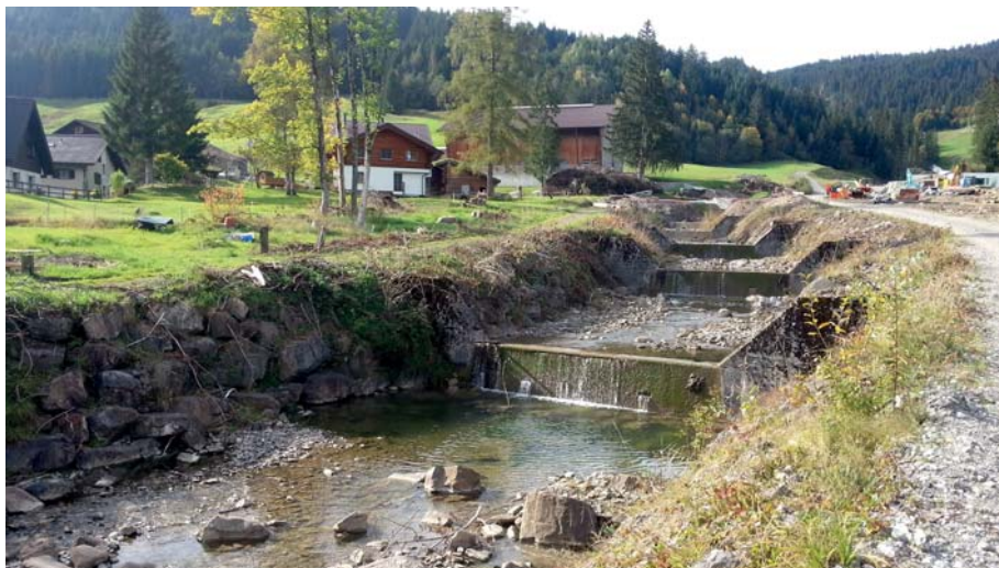
Bild 1. Ausleitstrecke mit klassischen Betonsperren vor dem Umbau.
